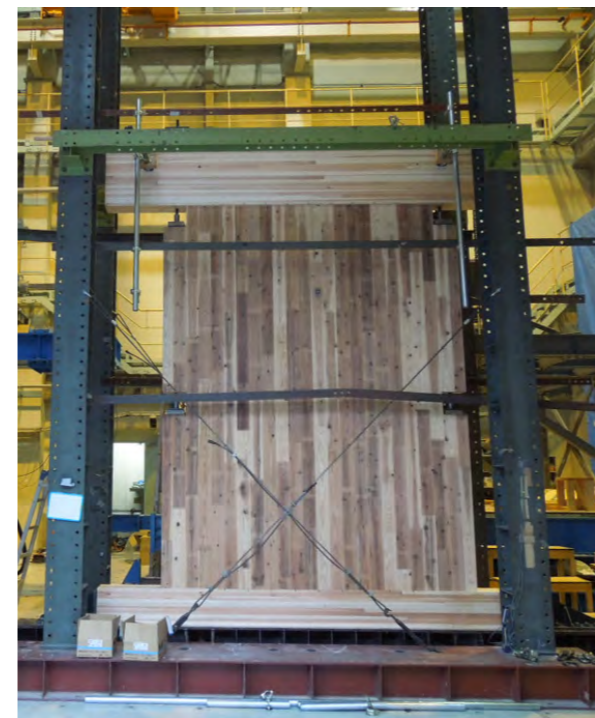
高知県自治会館・CLT 実験
